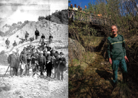
1912-21 fi763 Pont sur le torrent de la grande Combe - canal de dérivation
